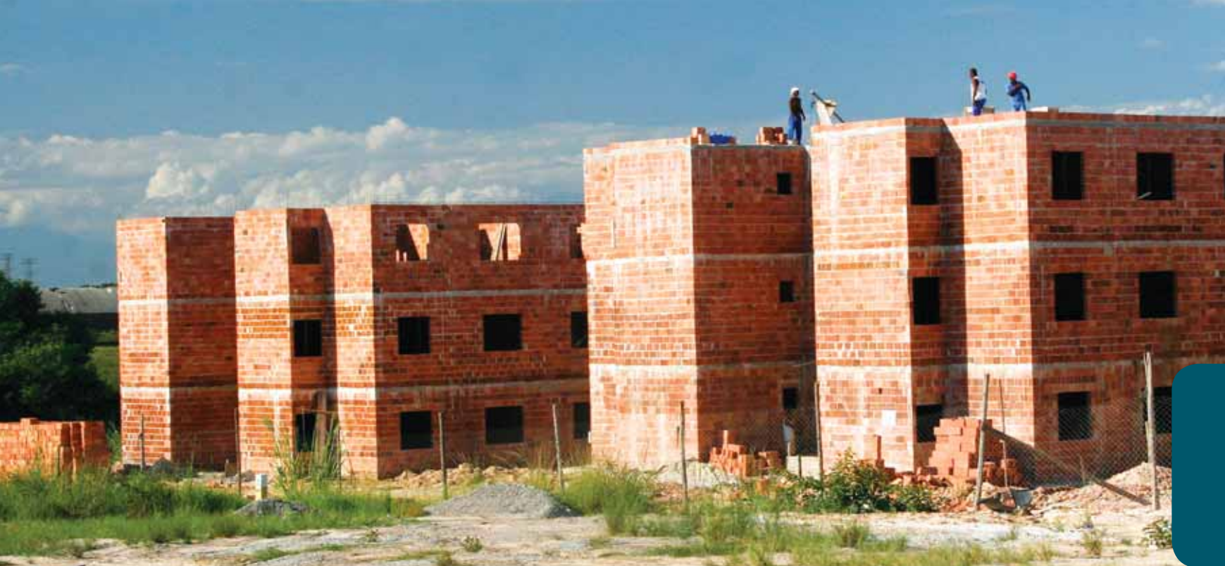
Conjunto habitacional em construção na BR 493, bairro Itambi, no 3º Distrito
