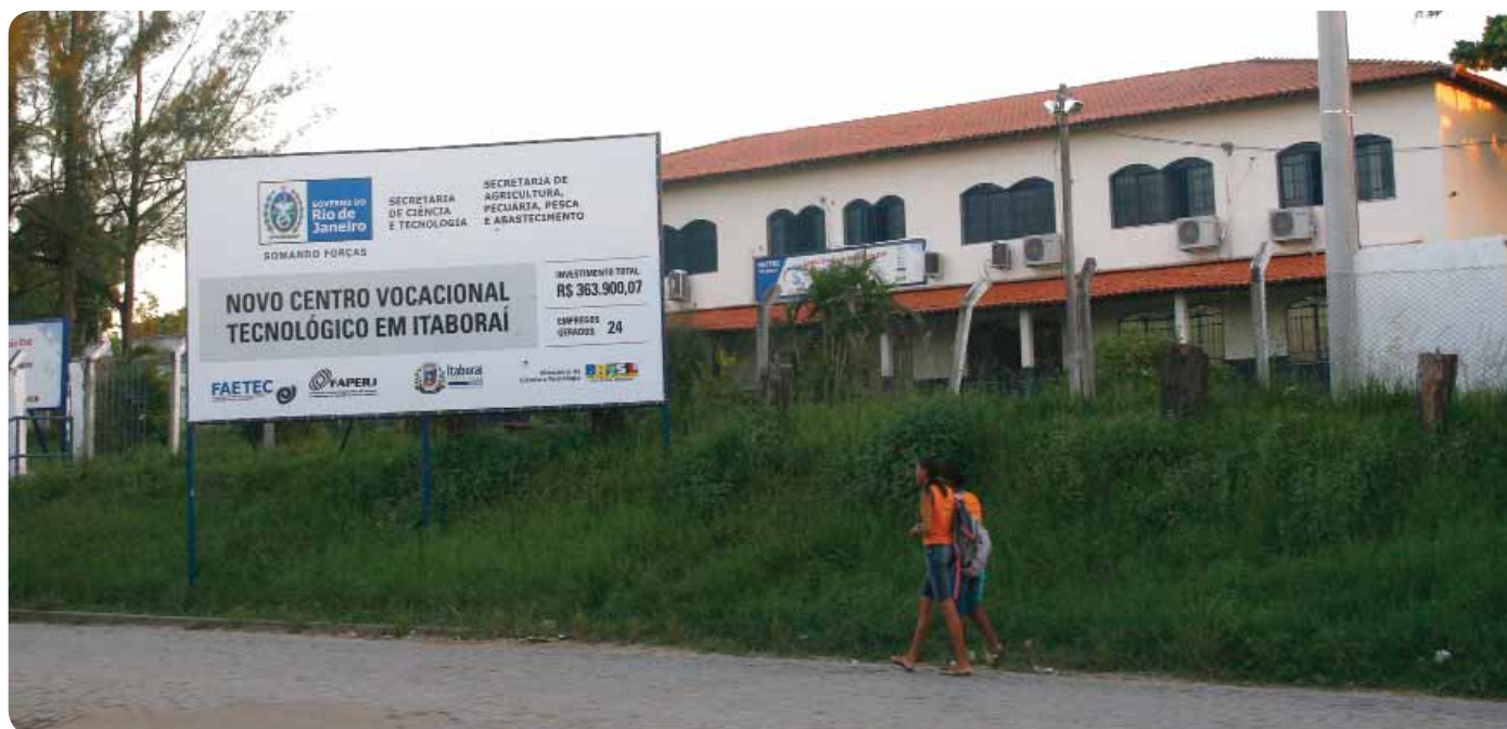
O Centro Vocacional de Itaboraí forma técnicos na área de construção civil
