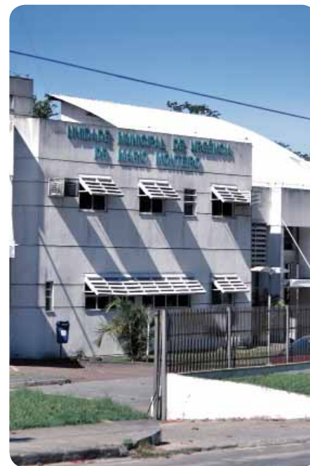
Unidade Municipal de Urgência Dr. Mário Monteiro, em Piratininga
