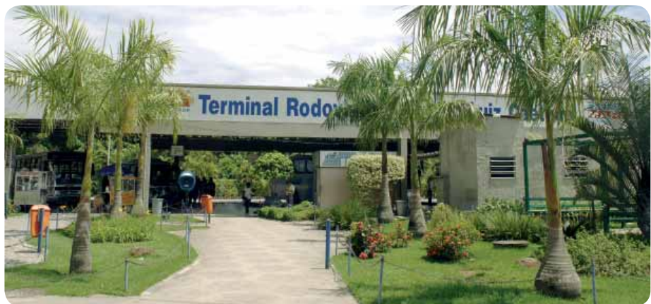
Rodoviária no centro de Maricá
