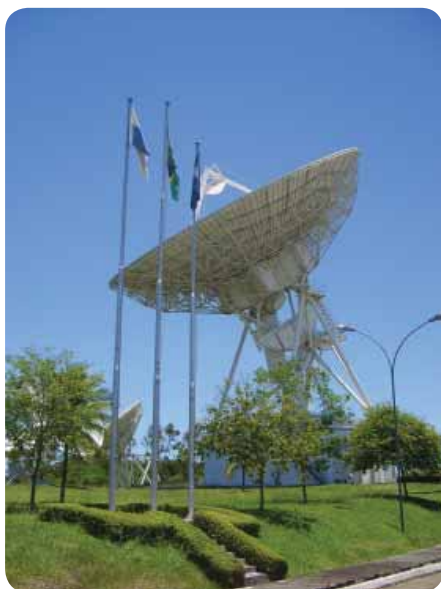
A primeira Estação Terrena de Comunicação por Satélites do Brasil foi instalada em Tanguá
