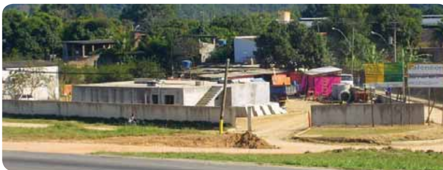
Estação de Tratamento de Esgotos de Tanguá
