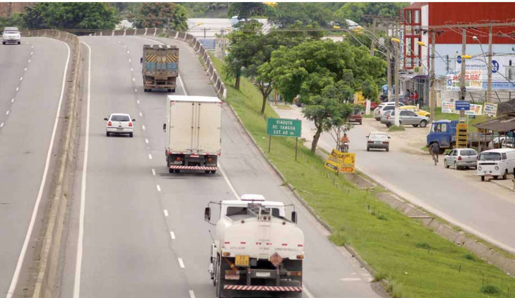
Viaduto de Tanguá na BR-101
