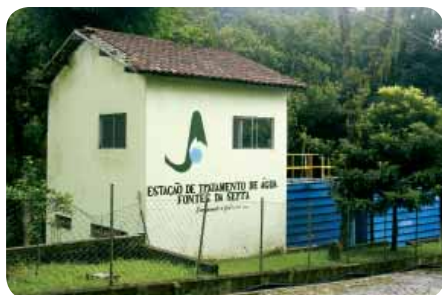
Estação de Tratamento de Água Fontes da Serra
