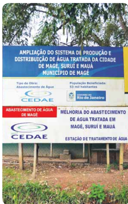
Canteiro de obras de saneamento no Bairro de Maria Conga
