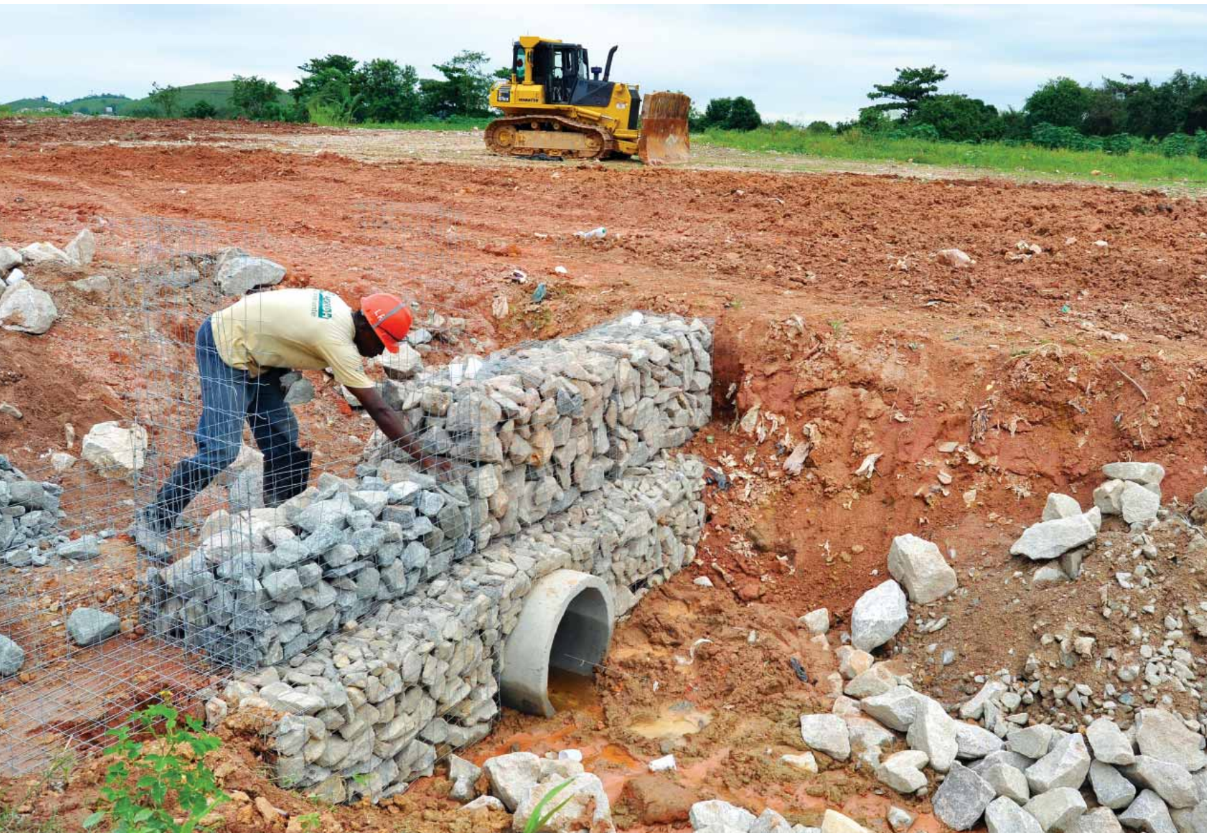
Aterro sanitário em construção em Bongaba – 6º Distrito
